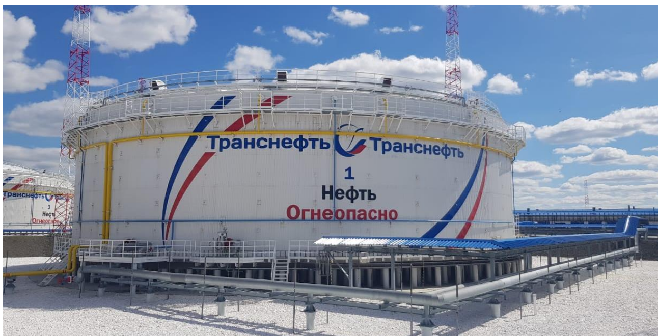
Рисунок 1 – Общий вид резервуара РВСП-20000
