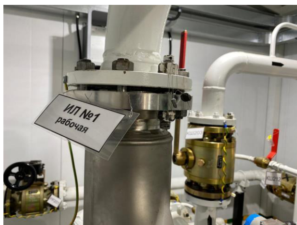
Рисунок 4 – Пломбирование на фланцевых соединениях первичного преобразователя датчика Promass F
