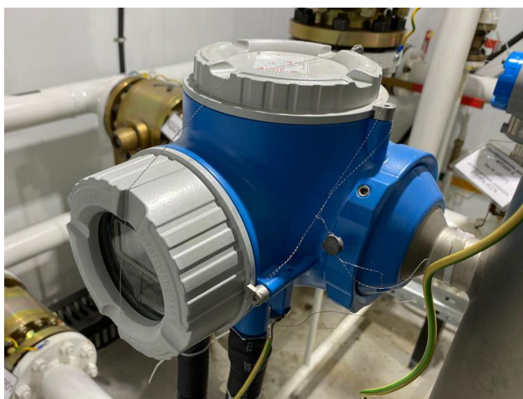
Рисунок 3 – Пломбирование корпуса электронного преобразователя Promass 300
