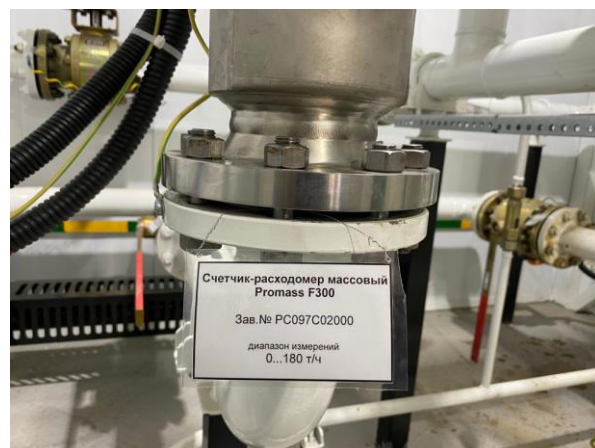
Рисунок 4 – Пломбирование на фланцевых соединениях первичного преобразователя датчика Promass F
