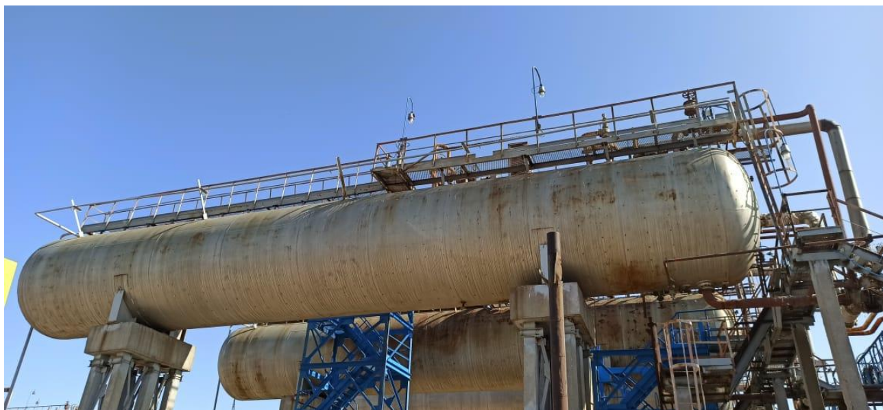
Рисунок 1 – Общий вид резервуаров РГС-200 зав.№ 1810, 2812, 2813
