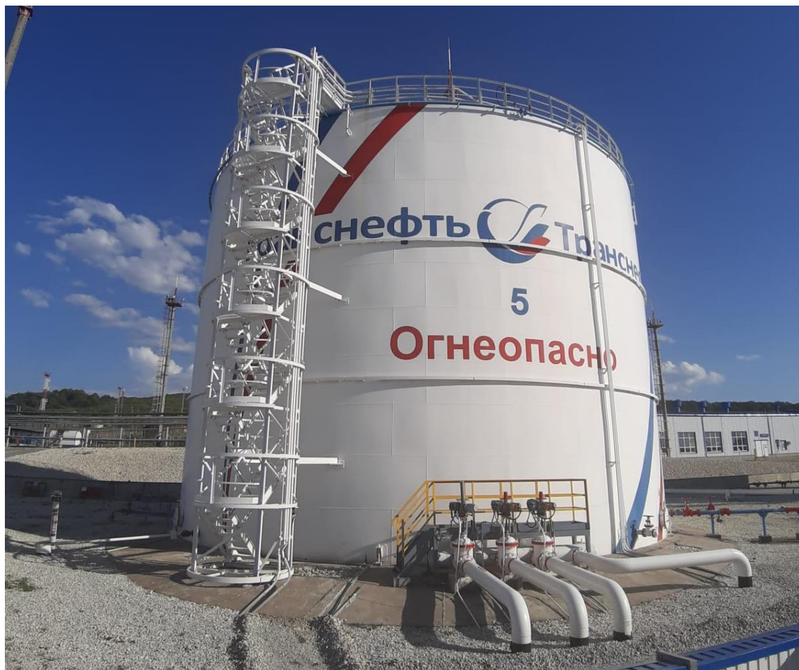
Рисунок 1 – Общий вид резервуаров РВС-5000
