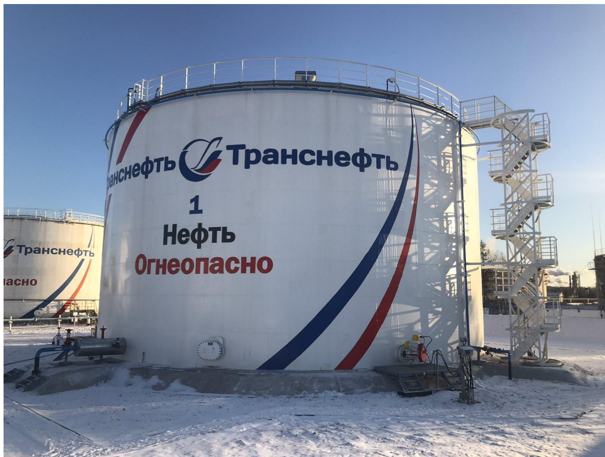
Рисунок 1 – Общий вид резервуара РВС-5000
