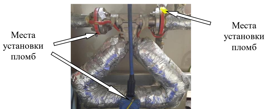
Рисунок 2 – Схема пломбировки от несанкционированного доступа счетчика-расходомера массового Micro Motion модели CMF100 с измерительным преобразователем RFT9739**
