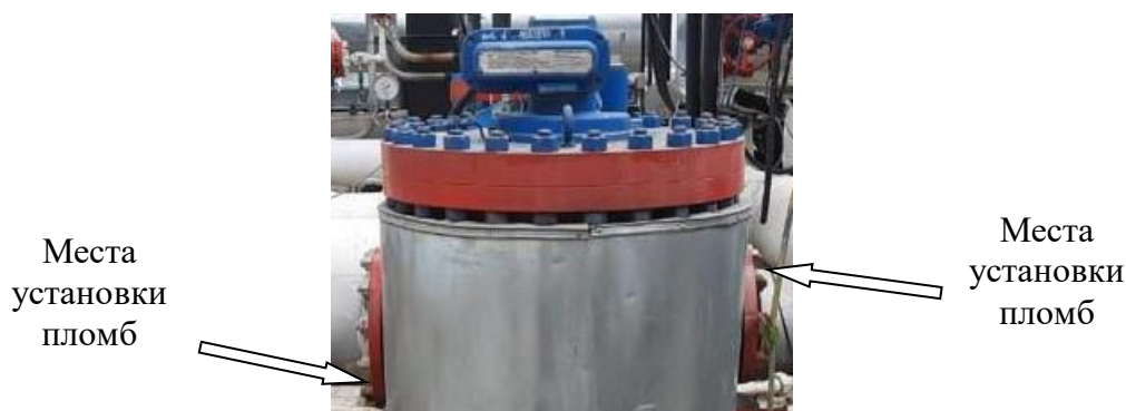
Рисунок 1 – Схема пломбировки от несанкционированного доступа ПР*
