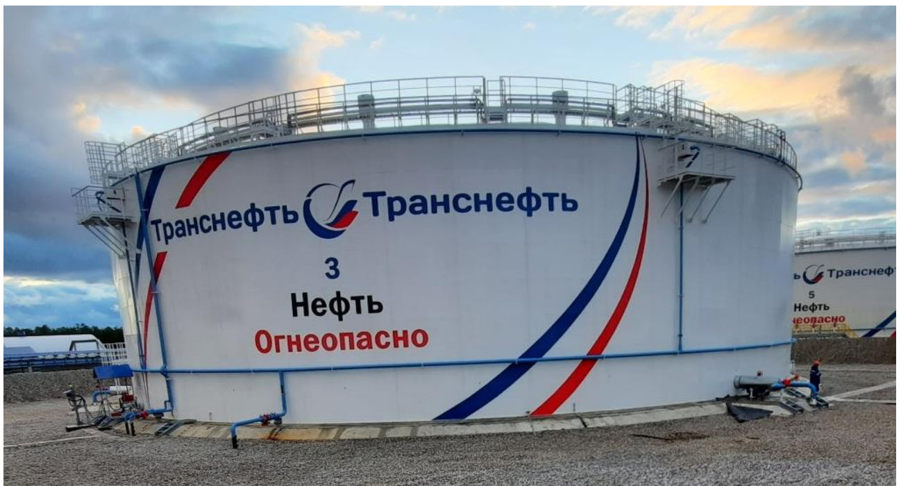
Рисунок 1 – Общий вид резервуара вертикального стального цилиндрического РВСП-20000, заводской номер 3
