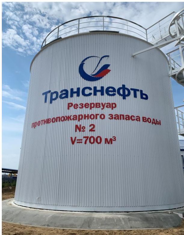
Рисунок 2 – Общий вид резервуара РВС-700 с заводским номером 352.2
