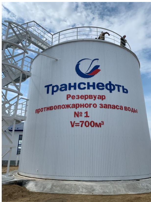
Рисунок 1 – Общий вид резервуара РВС-700 с заводским номером 352.1
