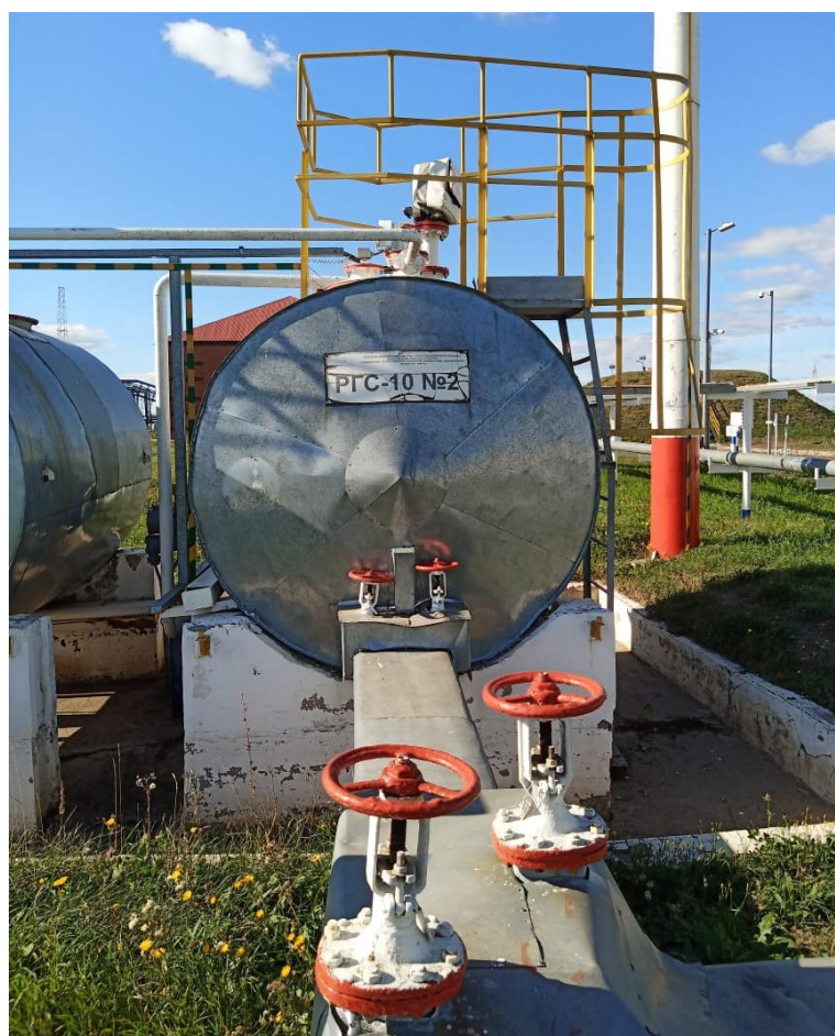
Рисунок 3 – Общий вид резервуара РГС-10 с заводским номером 2
