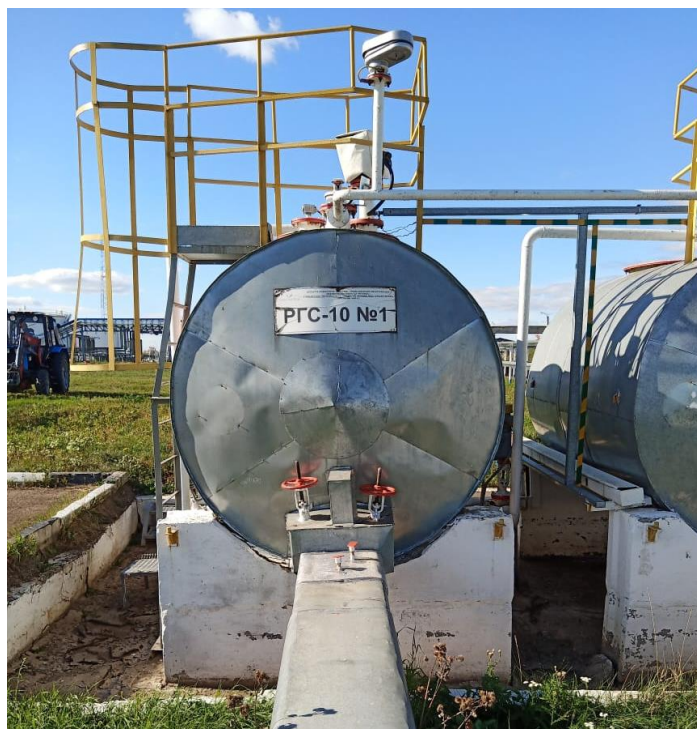
Рисунок 2 – Общий вид резервуара РГС-10 с заводским номером 1
