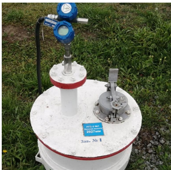
Рисунок 1 – Общий вид резервуара РГС-3
