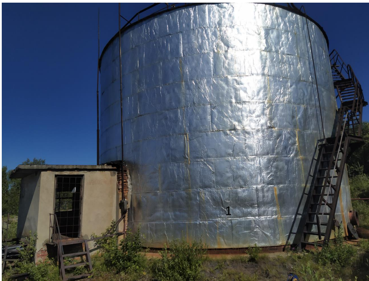
Рисунок 1 – Общий вид резервуара РВС-1000
