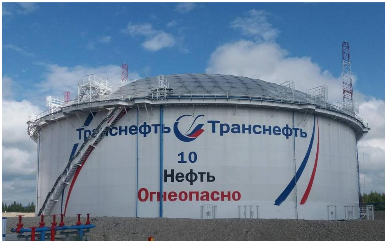
Рисунок 1 – Общий вид резервуара РВСПА-50000
