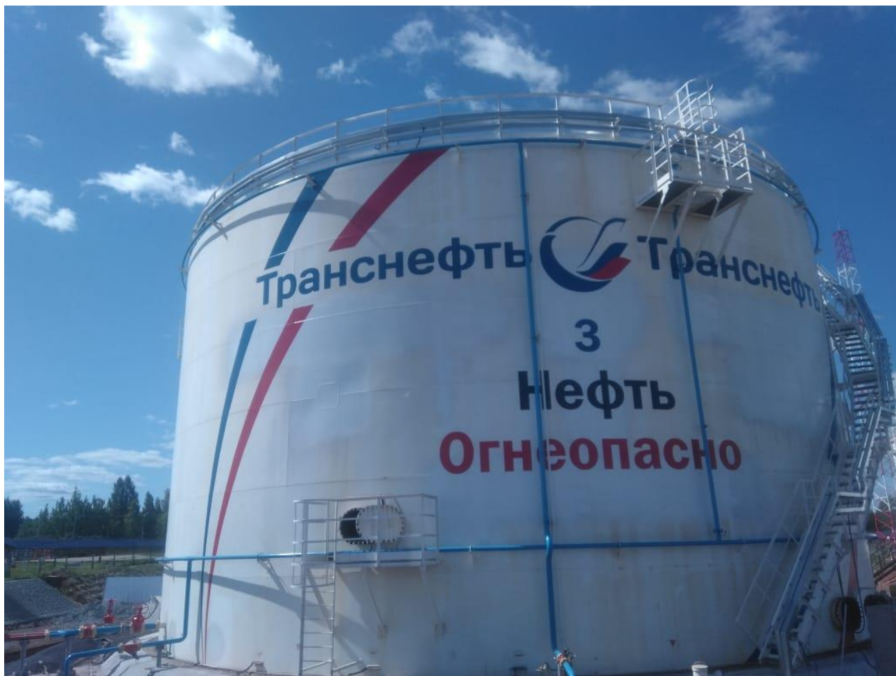
Рисунок 1 – Общий вид резервуара РВСП-5000
