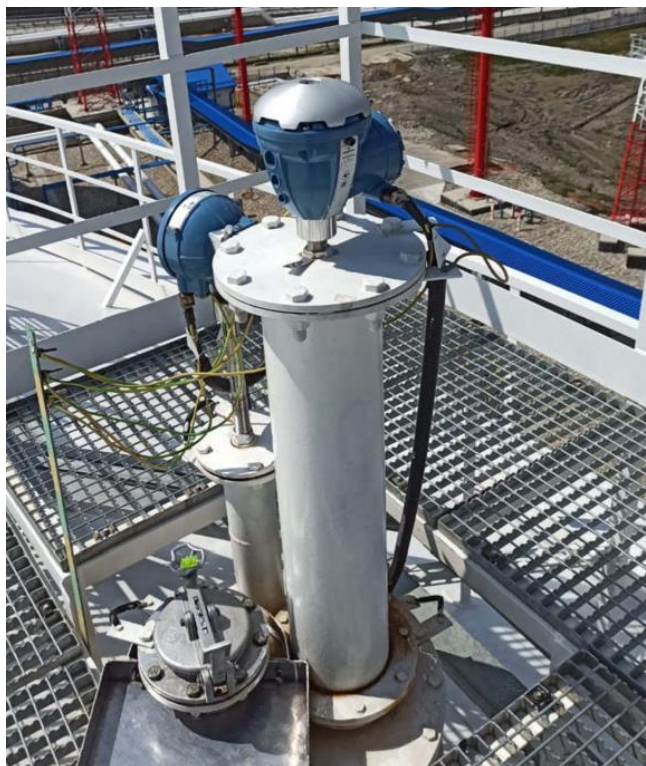
Рисунок 3 – Общий вид резервуаров РВС-30000
