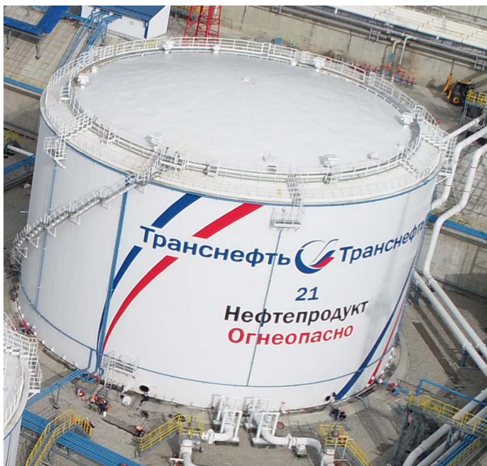
Рисунок 2 – Общий вид резервуара РВС-30000 зав. № 21
