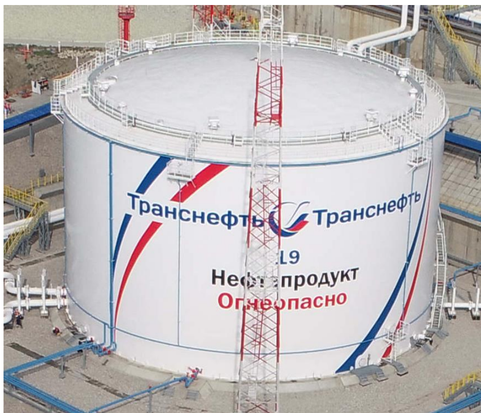
Рисунок 1 – Общий вид резервуара РВС-30000 зав. № 19
