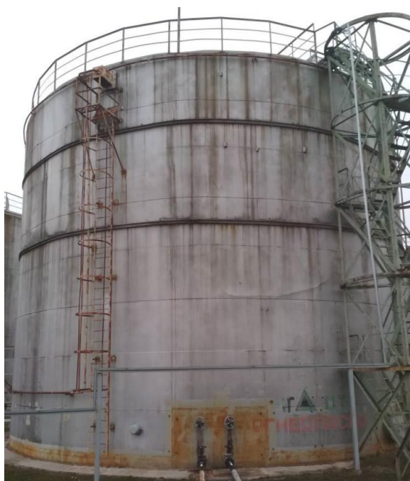
Рисунок 1 – Общий вид резервуаров РВС-2000
