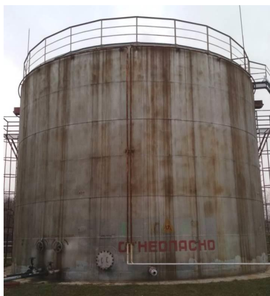
Рисунок 1 – Общий вид резервуаров РВС-1000
