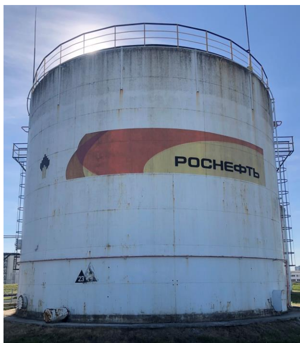
Рисунок 1 – Общий вид резервуаров РВСП-2000
