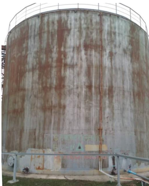
Рисунок 1 – Общий вид резервуара РВСП-2000
