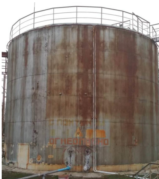
Рисунок 1 – Общий вид резервуаров РВСП-1000
