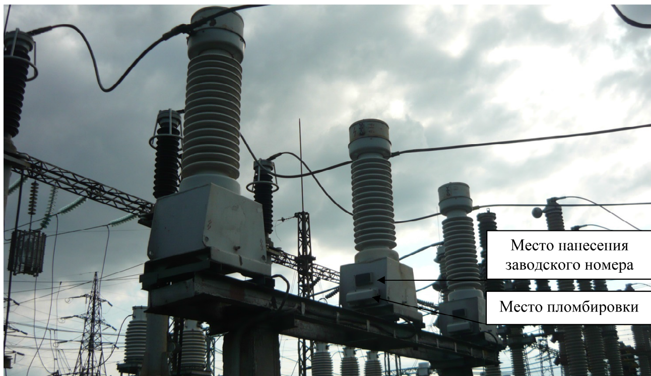
Рисунок 1. Общий вид средства измерений с указанием места пломбировки, места нанесения заводского номера
