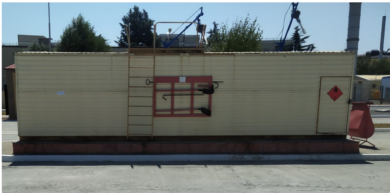
Рисунок 2 – Место расположения резервуаров РГС-10 с заводскими номерами 2/1, 2/2
