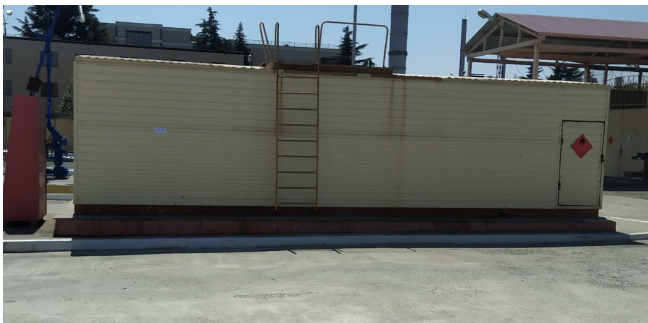
Рисунок 1 – Место расположения резервуаров РГС-10 с заводскими номерами 1/1, 1/2
