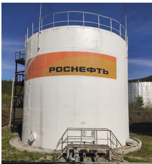
Рисунок 1 – Общий вид резервуаров РВС-700
