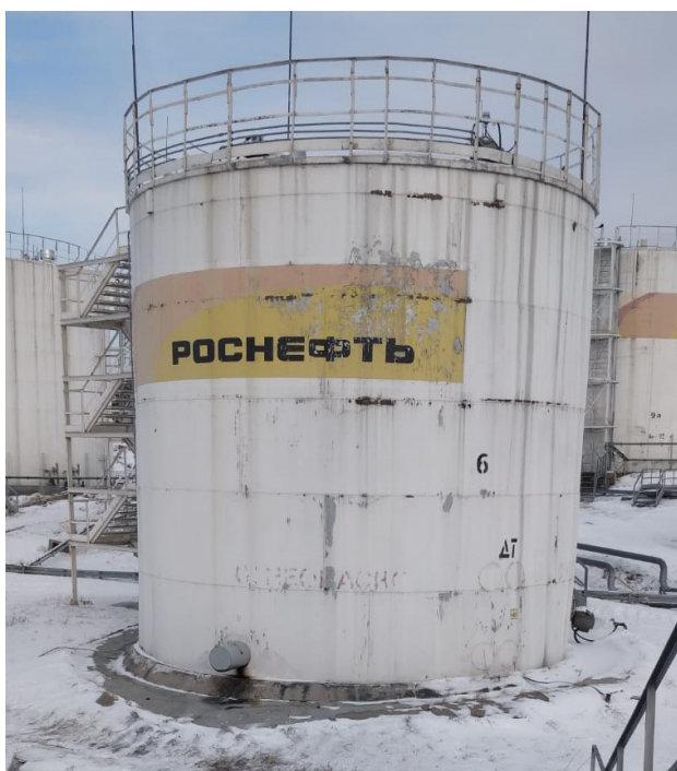
Рисунок 1 – Общий вид резервуара РВС-300
