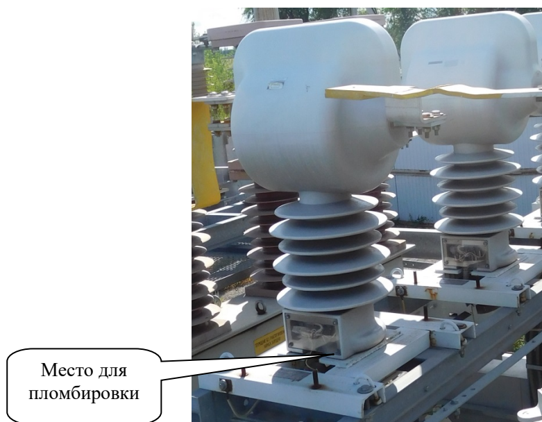
Рисунок 1 – Общий вид и схема пломбировки от несанкционированного доступа трансформаторов тока ТОЛ-35 III-II-1 УХЛ1
