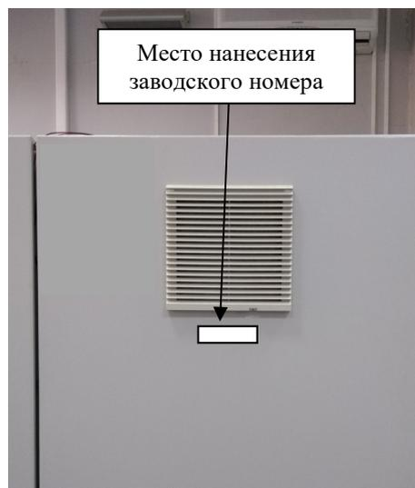
Рисунок 3 – Шкаф управления системы в сборе с указанием места расположения
