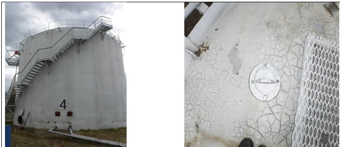
Рисунок 2 – Общий вид резервуаров РВС-1000 (№4) с замерным люком
