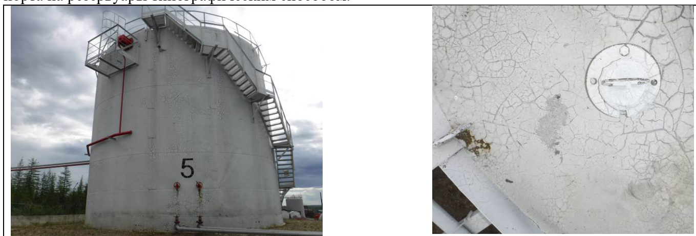
Рисунок 1 – Общий вид резервуаров РВС-700 (№5) с замерным люком
