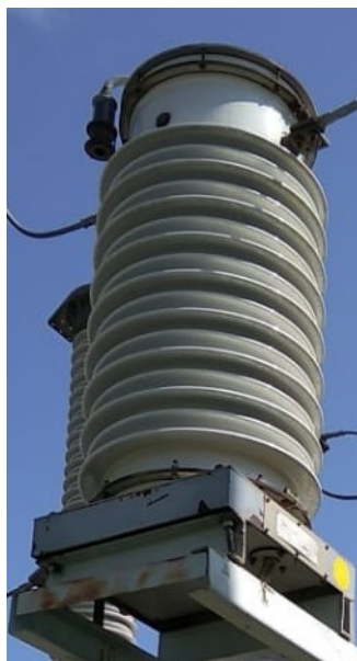
Рисунок 1 - Общий вид трансформаторов тока ТФЗМ 110Б-IV У1
