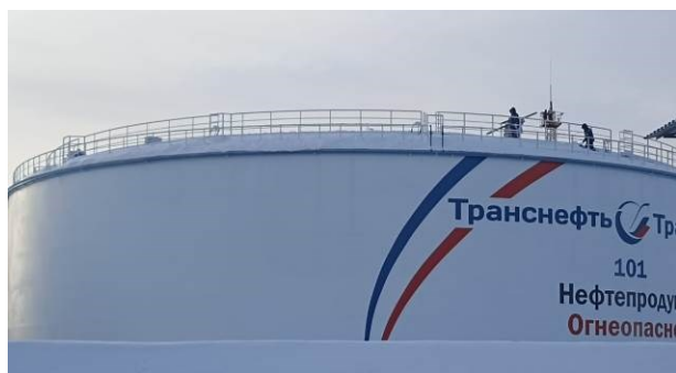
Рис. 1 – Общий вид РВС-20000 зав.№101
