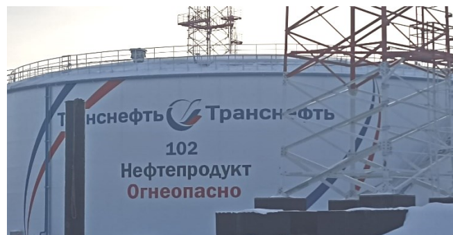
Рис. 2 – Общий вид РВС-20000 зав.№102
