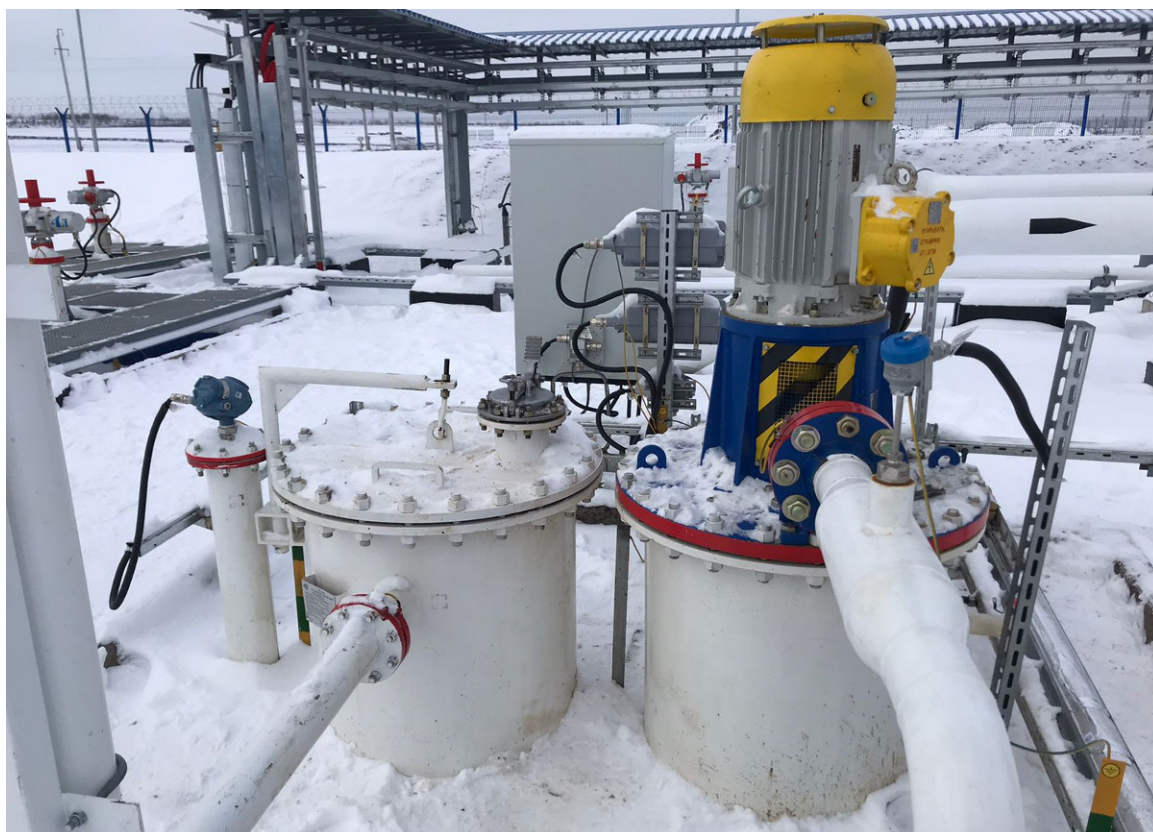
Рисунок 2 – Общий вид резервуара ЕП-5-1600-1500-А-СО-У1
