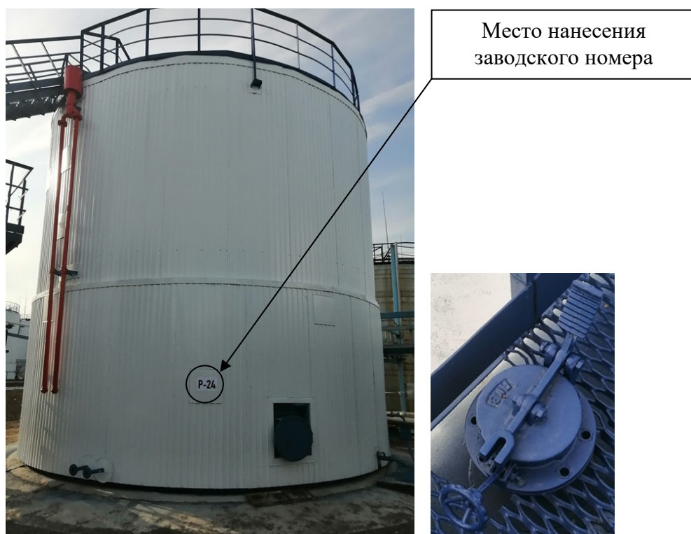
Р и с у н о к 3 – Общий вид резервуара с заводским номером P-24 и его замерного люка
