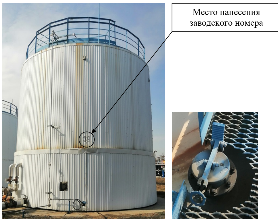
Р и с у н о к 2 – Общий вид резервуара с заводским номером 39 и его замерного люка
