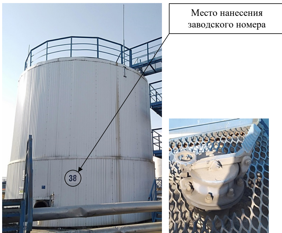
Р и с у н о к 1 – Общий вид резервуара с заводским номером 38 и его замерного люка
