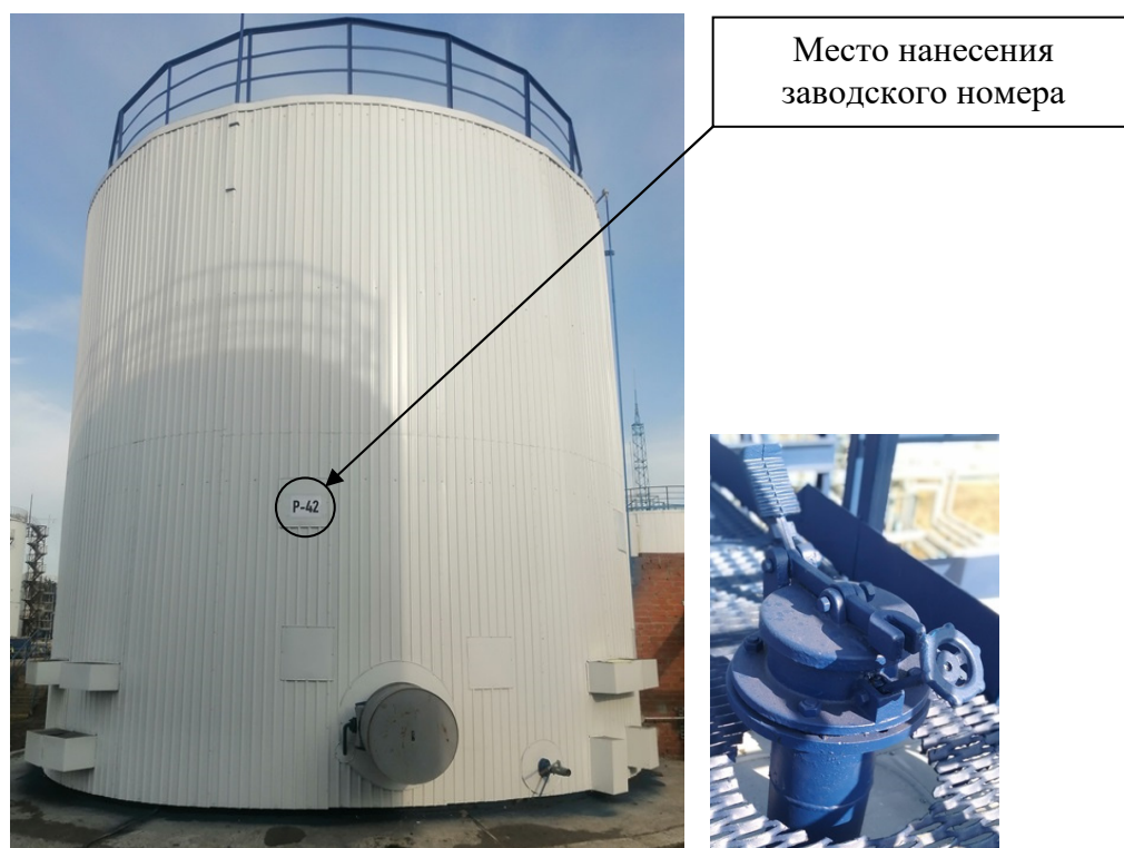
Р и с у н о к 6 – Общий вид резервуара с заводским номером P-42 и его замерного люка
