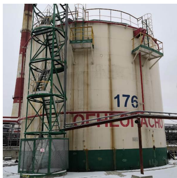
Рисунок 10 – Общий вид резервуаров РВСП-2000 № 176
