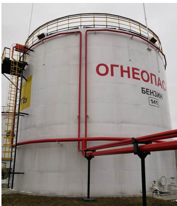
Рисунок 2 – Общий вид резервуаров РВСП-2000 № 141
