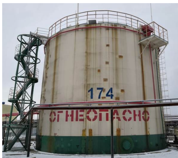
Рисунок 8 – Общий вид резервуаров РВСП-2000 № 174
