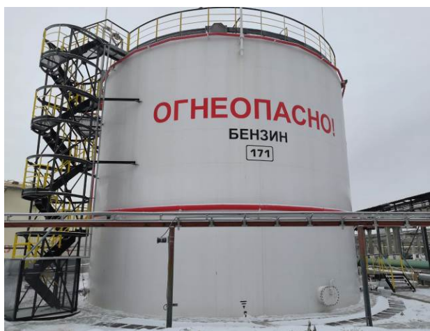
Рисунок 5 – Общий вид резервуаров РВСП-2000 № 171
