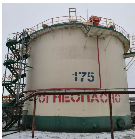
Рисунок 9 – Общий вид резервуаров РВСП-2000 № 175
