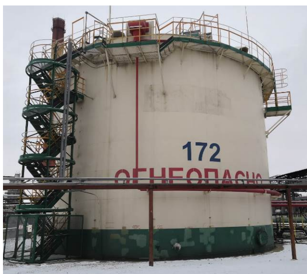
Рисунок 6 – Общий вид резервуаров РВСП-2000 № 172
