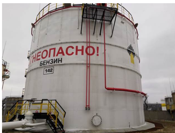
Рисунок 3 – Общий вид резервуаров РВСП-2000 № 142
