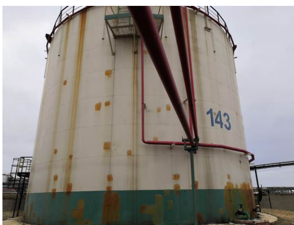
Рисунок 4 – Общий вид резервуаров РВСП-2000 № 143
