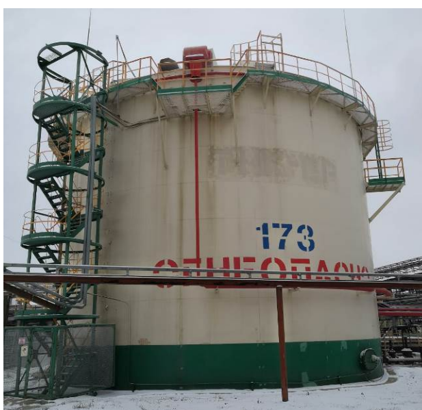
Рисунок 7 – Общий вид резервуаров РВСП-2000 № 173
