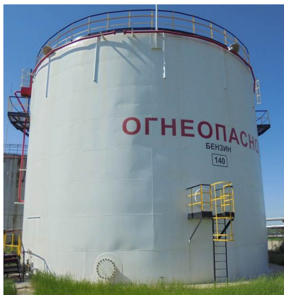
Рисунок 1 – Общий вид резервуара РВСП-2000 № 140
