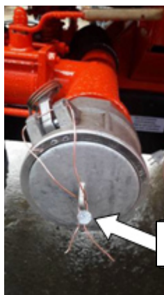
Рисунок 4 – Пломбировка трубопровода слива-налива
