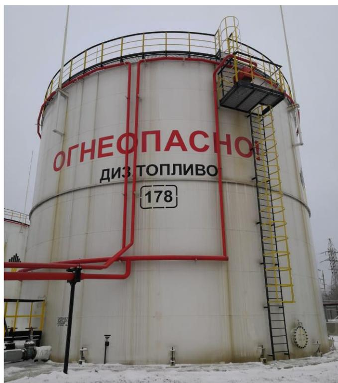
Рисунок 2 – Общий вид резервуара РВС-2000 № 178
