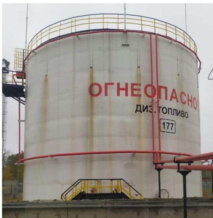
Рисунок 1 – Общий вид резервуара РВС-2000 № 177
