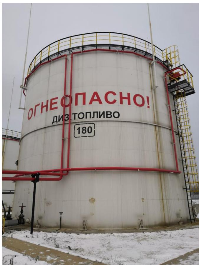
Рисунок 4 – Общий вид резервуара РВС-2000 № 180
