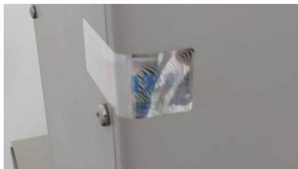
Рисунок 4 – Пример нанесения пломбировочной наклейки
