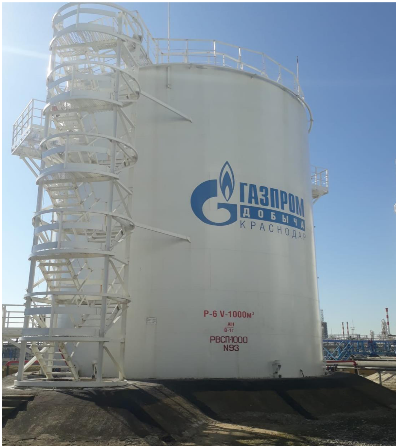
Рисунок 3 - Фотография общего вида резервуара РВСП-1000 заводской номер 93
