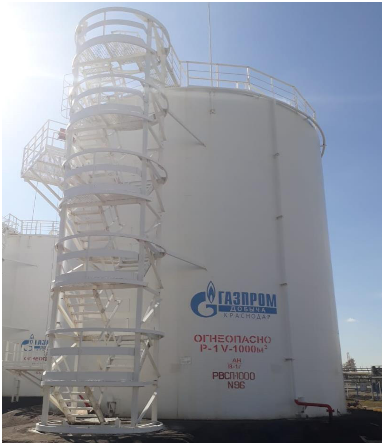
Рисунок 1 - Фотография общего вида резервуара РВСП-1000 заводской номер 96
