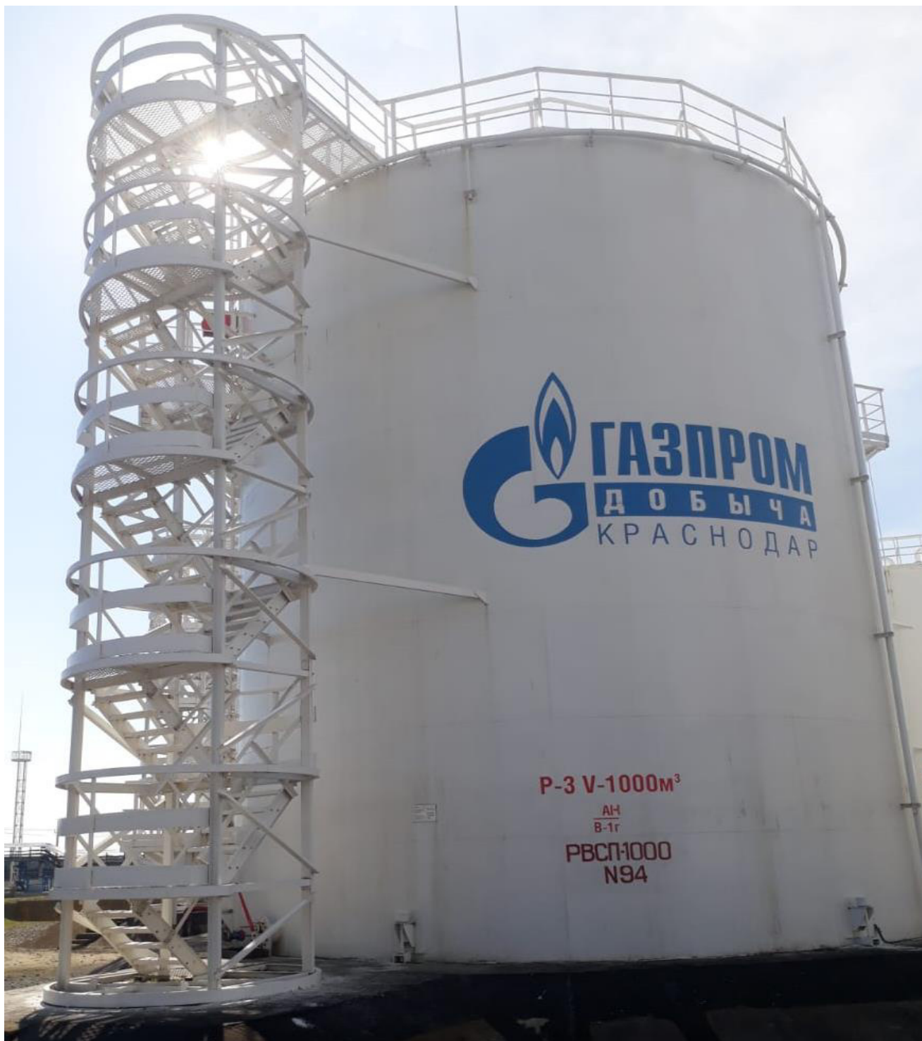
Рисунок 2 - Фотография общего вида резервуара РВСП-1000 заводской номер 94
