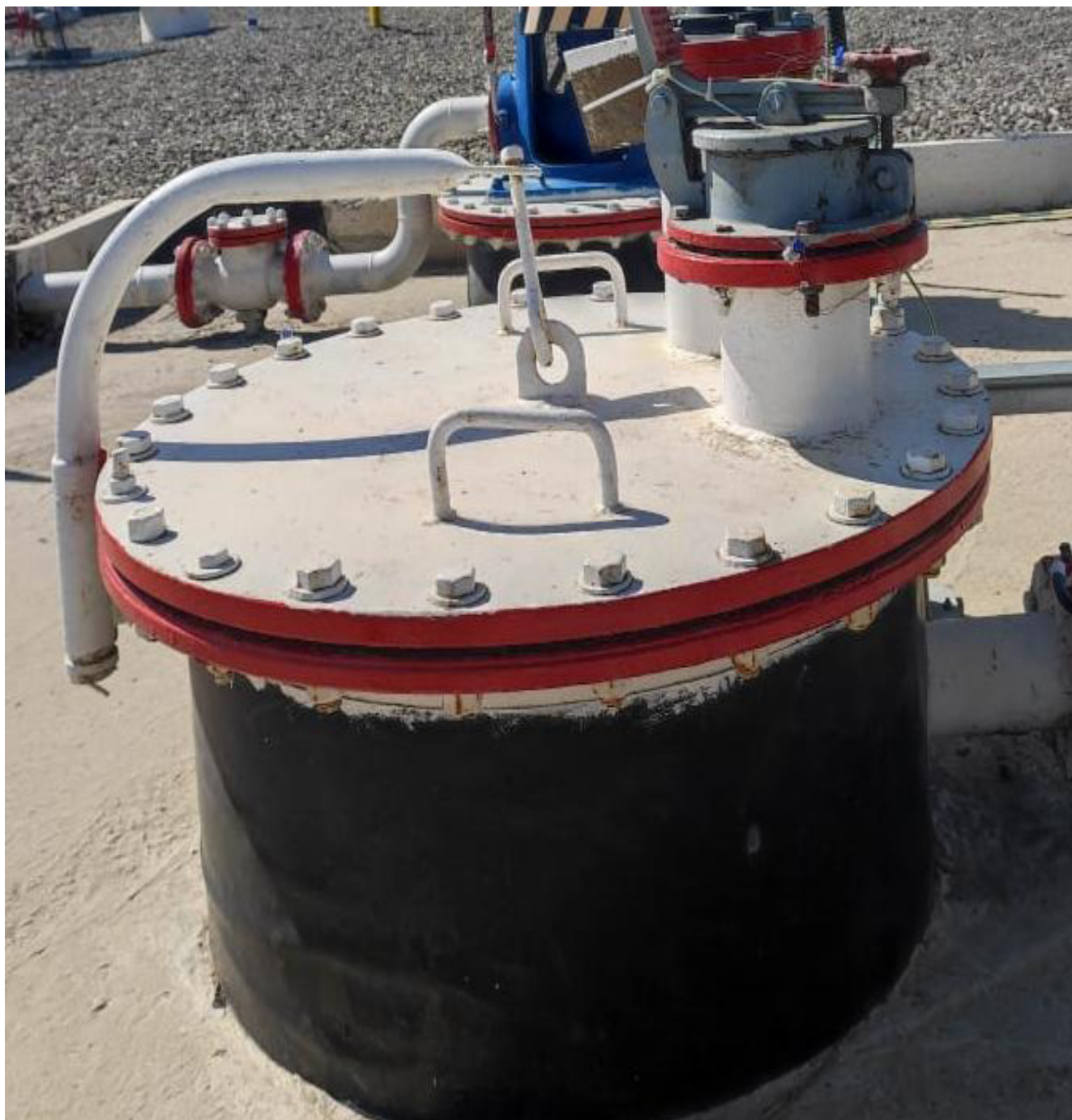
Рисунок 2 - Фотография горловины и крышки замерного люка резервуара
