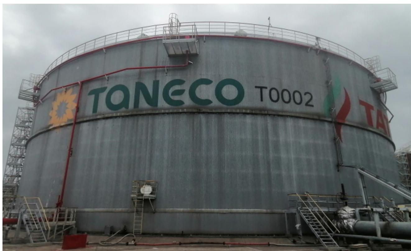
Рисунок 2 – Общий вид резервуара РВСП-50000 зав.№ Т0002
