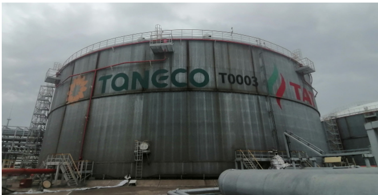
Рисунок 3 – Общий вид резервуара РВСП-50000 зав.№ Т0003
