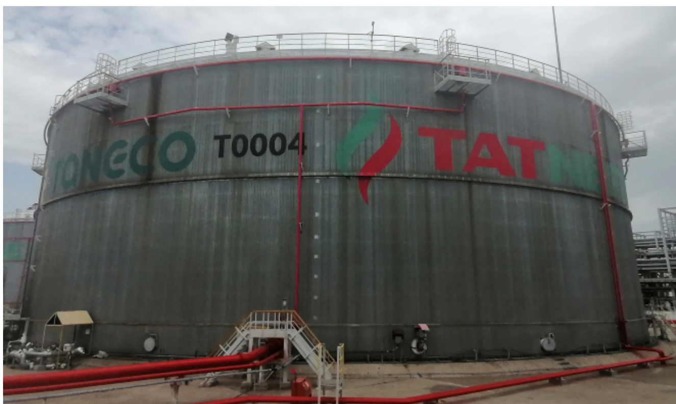
Рисунок 4 – Общий вид резервуара РВСП-50000 зав.№ Т0004
