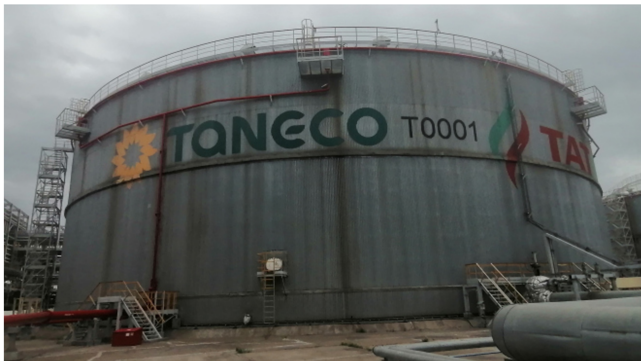
Рисунок 1 – Общий вид резервуара РВСП-50000 зав.№ Т0001
