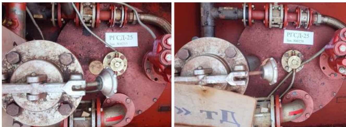
Рисунок 5 – Горловины и измерительные люки резервуаров РГСД-25 зав.№№ 0255, 0258 Пломбирование резервуаров РГСД-25 не предусмотрено.
