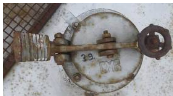
Рисунок 10 – Общий вид резервуара РВС-3000 (заводской номер 39) с замерным люком
