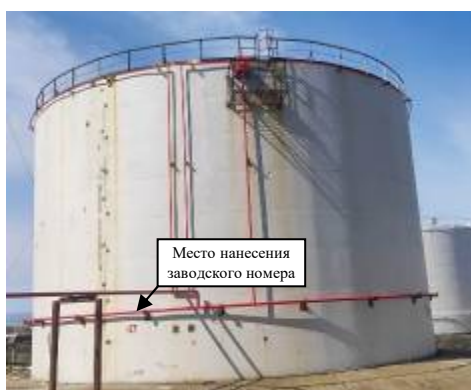
Рисунок 13 – Общий вид резервуара РВС-3000 (заводской номер 47) с замерным люком
