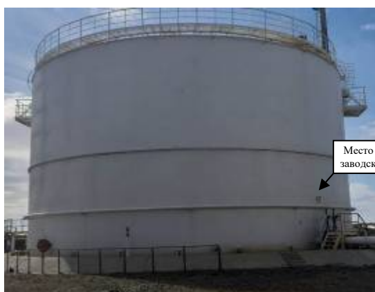
Рисунок 17 – Общий вид резервуара РВС-5000 (заводской номер 17) с замерным люком
