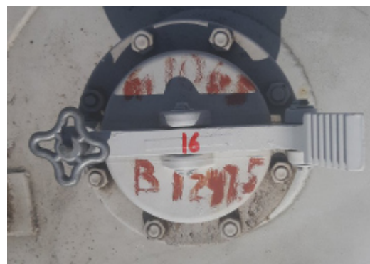
Рисунок 16 – Общий вид резервуара РВС-5000 (заводской номер 16) с замерным люком
