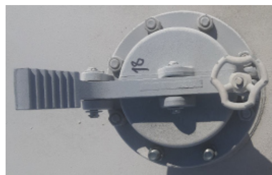
Рисунок 17 – Общий вид резервуара РВС-5000 (заводской номер 17) с замерным люком
