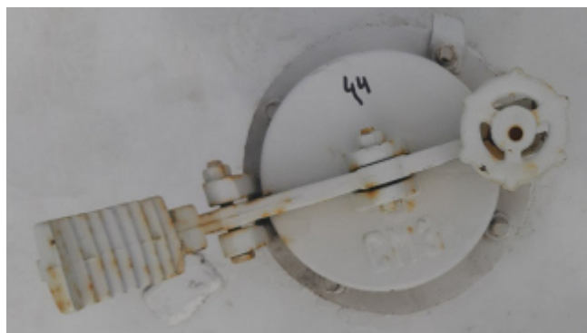
Рисунок 12 – Общий вид резервуара РВС-3000 (заводской номер 44) с замерным люком
