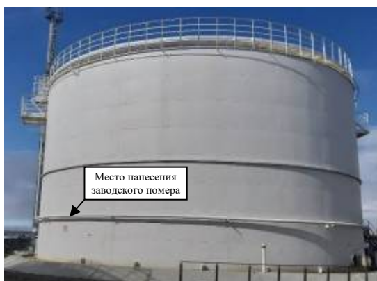
Рисунок 18 – Общий вид резервуара РВС-5000 (заводской номер 18) с замерным люком
