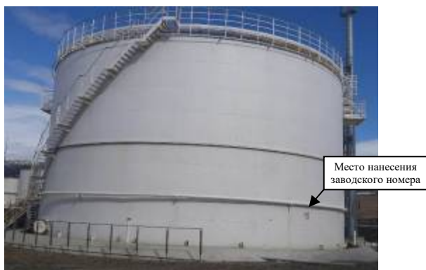
Рисунок 15 – Общий вид резервуара РВС-5000 (заводской номер 15) с замерным люком
