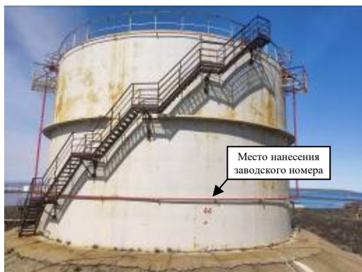
Рисунок 12 – Общий вид резервуара РВС-3000 (заводской номер 44) с замерным люком
