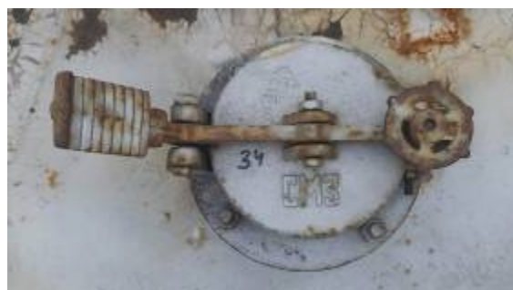
Рисунок 4 – Общий вид резервуара РВС-1000 (заводской номер 32) с замерным люком
