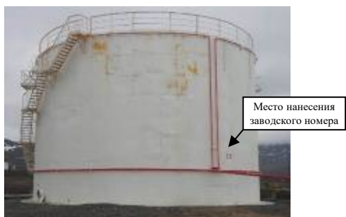
Рисунок 9 – Общий вид резервуара РВС-3000 (заводской номер 38) с замерным люком
