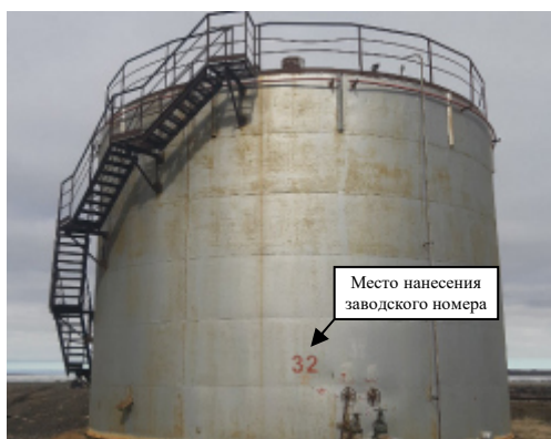
Рисунок 4 – Общий вид резервуара РВС-1000 (заводской номер 32) с замерным люком
