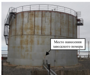
Рисунок 8 – Общий вид резервуара РВС-3000 (заводской номер 36) с замерным люком
