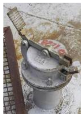
Рисунок 14 – Общий вид резервуара РВС-3000 (заводской номер 48) с замерным люком
