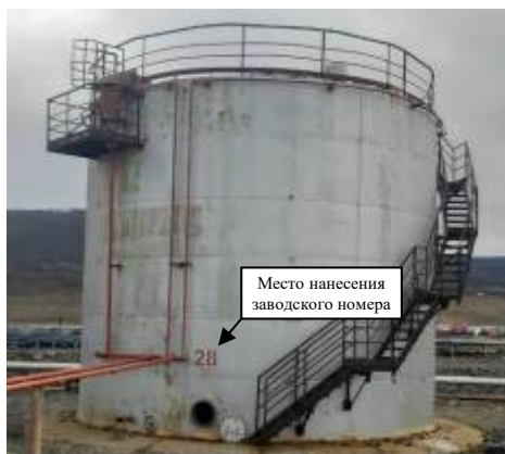
Рисунок 1 – Общий вид резервуара РВС-700 (заводской номер 28) с замерным люком
