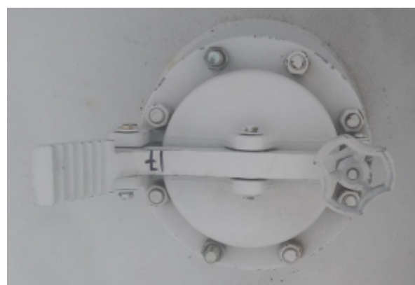
Рисунок 17 – Общий вид резервуара РВС-5000 (заводской номер 17) с замерным люком
