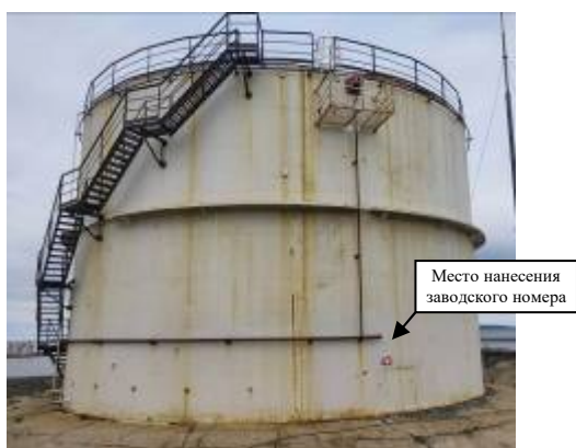
Рисунок 11 – Общий вид резервуара РВС-3000 (заводской номер 43) с замерным люком
