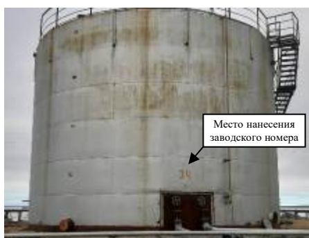
Рисунок 5 – Общий вид резервуара РВС-1000 (заводской номер 34) с замерным люком
