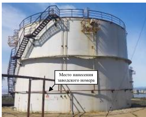
Рисунок 14 – Общий вид резервуара РВС-3000 (заводской номер 48) с замерным люком
