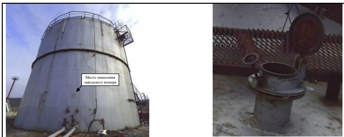
Рисунок 2 – Общий вид резервуара РВС-2000 (№35) с замерным люком
