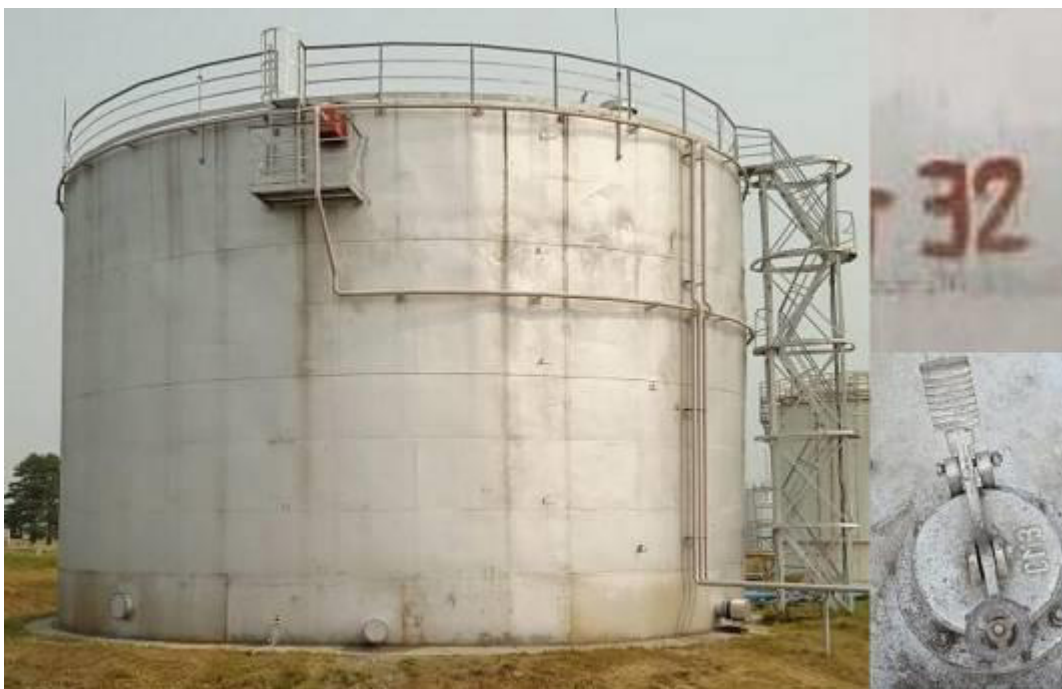
Рисунок 1 – фотография общего вида резервуара стального вертикального цилиндрического РВС-3000, горловины замерного люка и заводского номера
