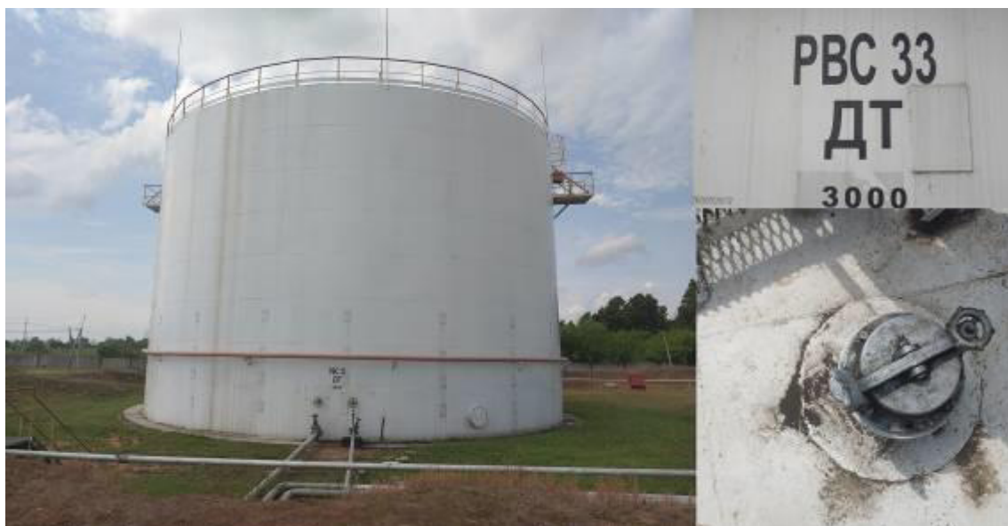
Рисунок 1 – Фотографии общего вида резервуара стального вертикального цилиндрического РВС- 3000, горловины замерного люка и заводского номера
