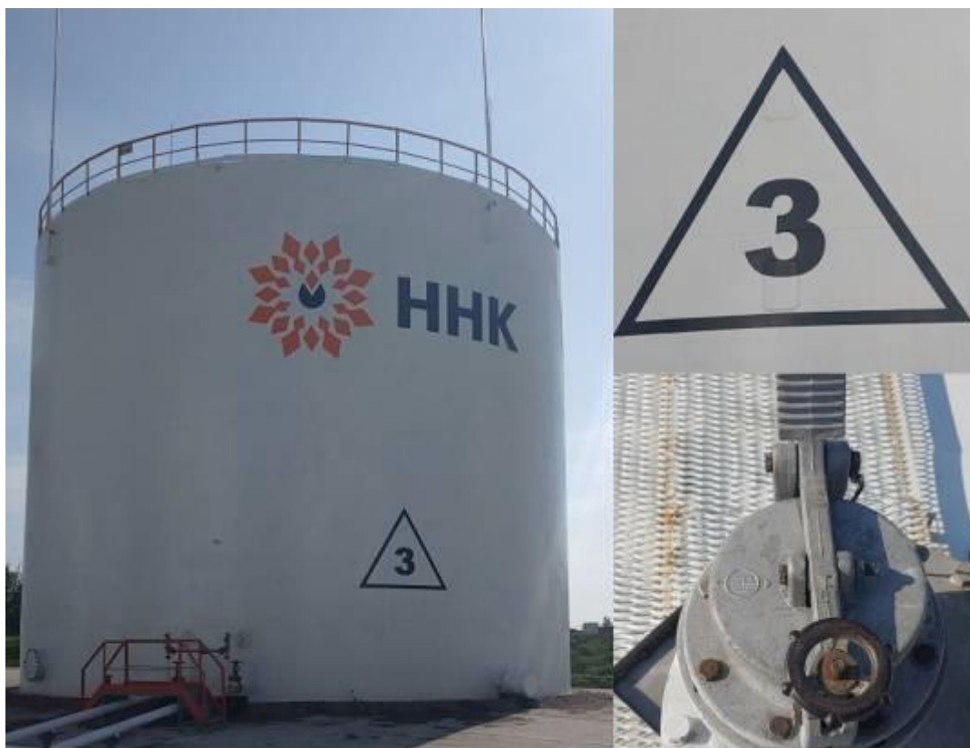
Рисунок 1 – Фотография общего вида резервуара стального вертикального цилиндрического РВСП- 2000, горловины замерного люка и заводского номера
