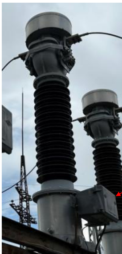
Рисунок 1 – Общий вид средства измерений, обозначение места пломбировки от несанкционированного доступа (А)
