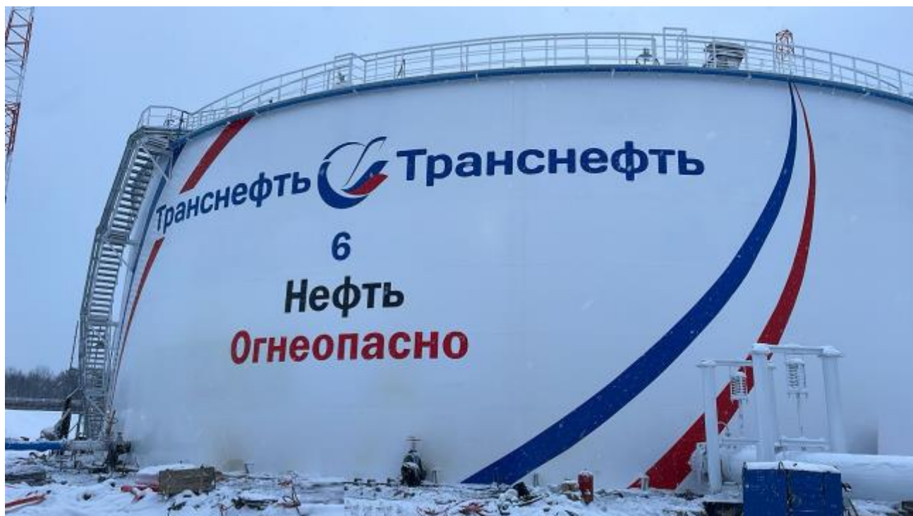
Рисунок 1 – Общий вид резервуара РВС-20000 зав.№ 6
