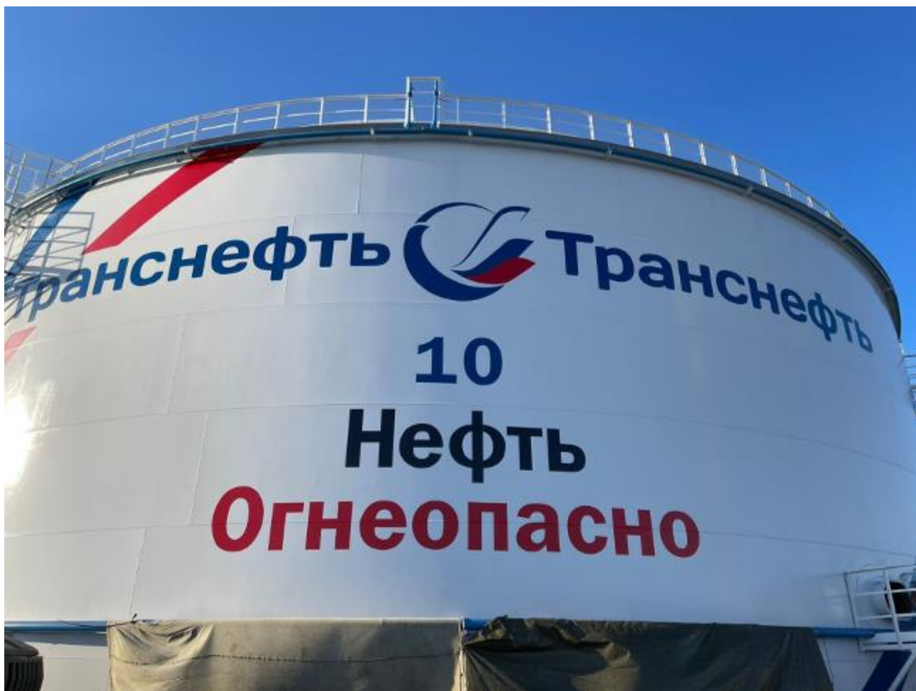
Рисунок 1 – Общий вид резервуара РВСП-10000 зав.№ 10
